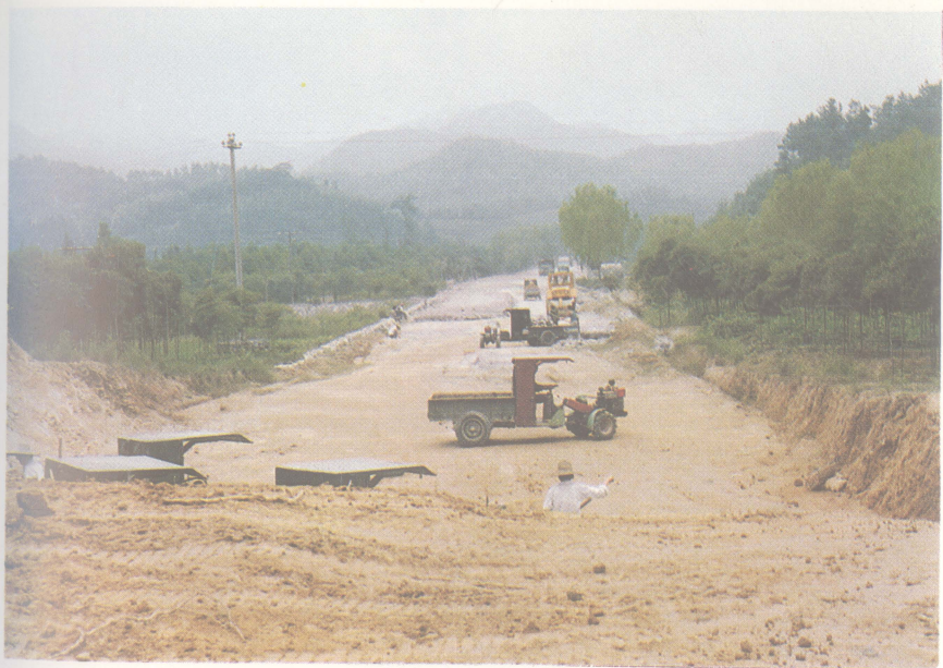
104国道水泥路面工程——上柏段施工
