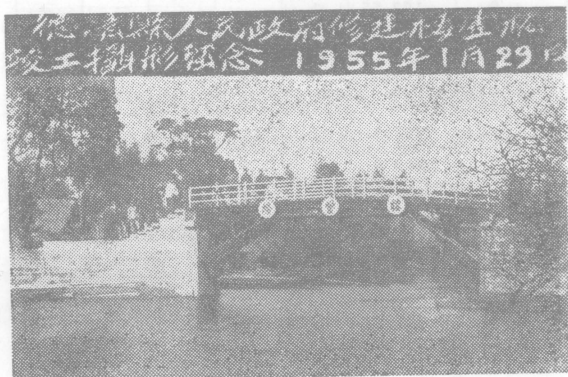
禹越乡栖丰桥木桥
