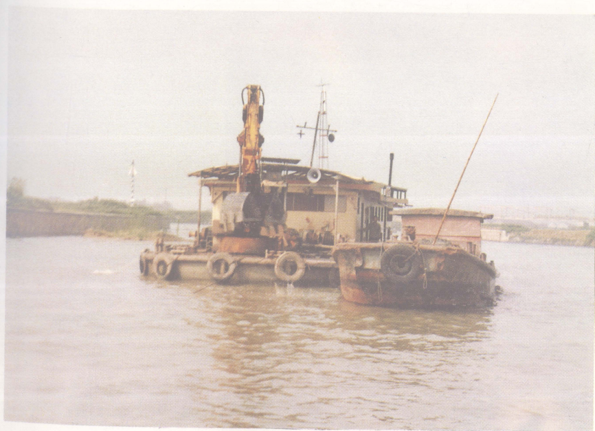
运河中线新市段在疏浚中
